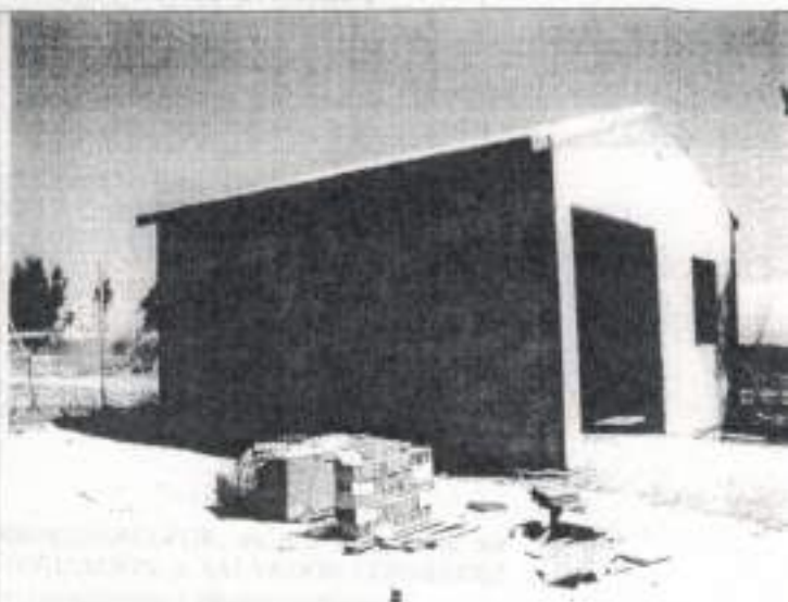
FOTO Nº 2 VISTA LATERAL DE LA CONSTRUCCIÓN DE MENOR SUPERFICIE.
