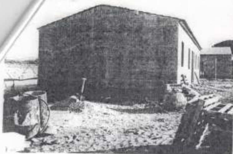
FOTO Nº 1. VISTA DE UNO DE LOS LATERALES DE LA CONSTRUCCIÓN
