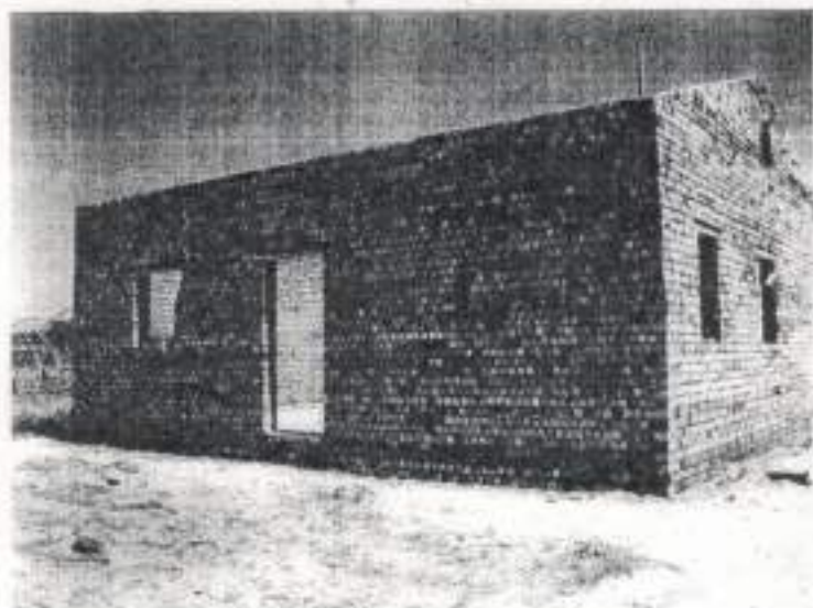
FOTO Nº 3 VISTA DE LA PARTE TRASERA DE LA CONSTRUCCIÓN DE MAYOR SUPERFICIE.
