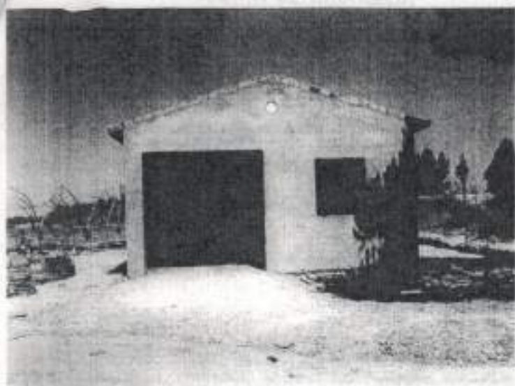
FOTO Nº 1 VISTA FRONTAL DE LA CONSTRUCCIÓN DE MENOR SUPERFICIE.
