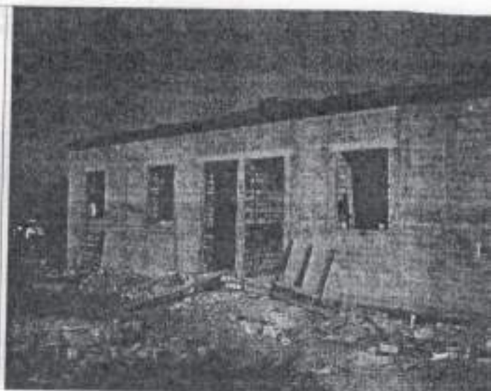
FOTO Nº 2. VISTA DE LA PARTE DELANTERA DE CONSTRUCCIÓN
